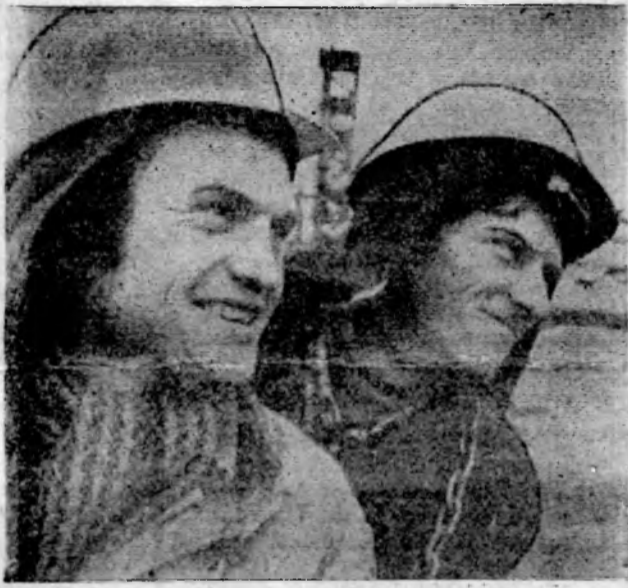
Комсомольцы Александр Ненашев и Юрий Хлюпин приехали на строительство Атоммаша по комсомольским путевкам. Работая в УС «Промстрой» монтажниками, они участвовали в строительстве ТЭЦ-2, а сейчас здесь же ведут монтаж административно-бытового корпуса.
